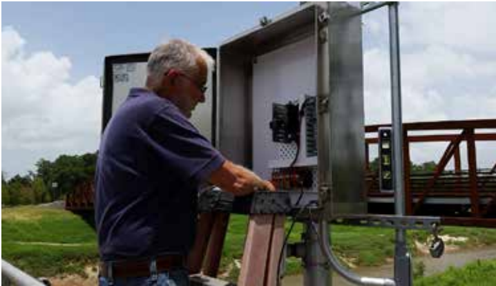
Instalación del sistema de Campbell en sitio existente de HCFCO
